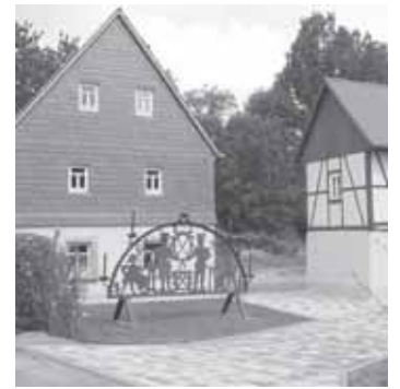
Das restaurierte historische Bergamtshaus
